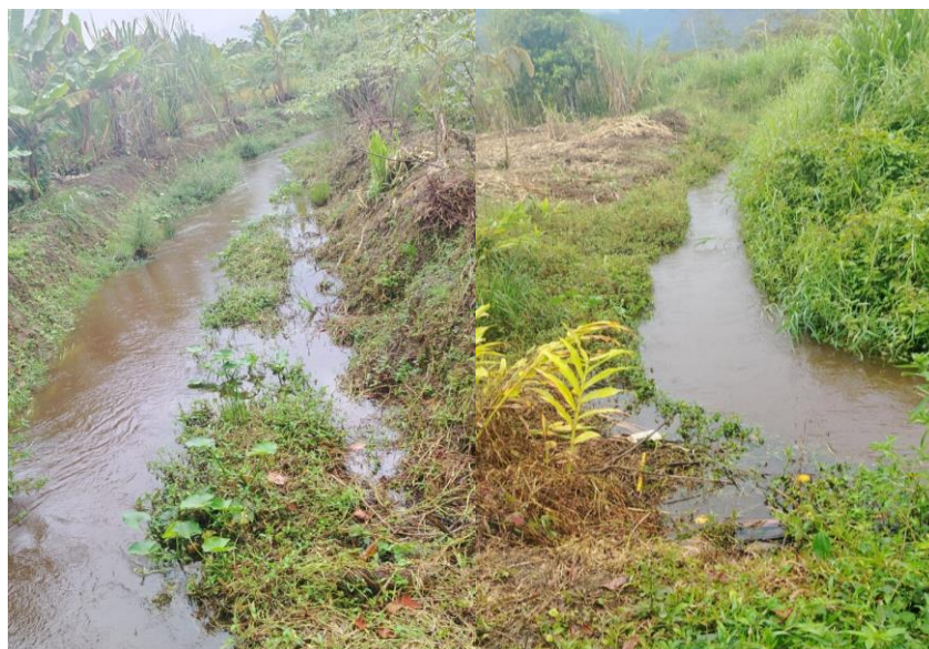
IMAGEN N°02: En las vistas fotograficas se observa el cauce de la quebrada rio Chico, con maleza y colmatado
